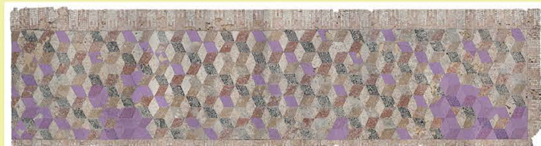
Localisation des réfections modernes dans les cubes (zones mauves)
